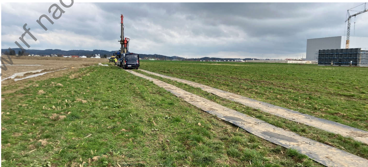
Abbildung 3 Erstellung GWM D2 (Blickrichtung Ost, Bodenschutz mit Platten)
