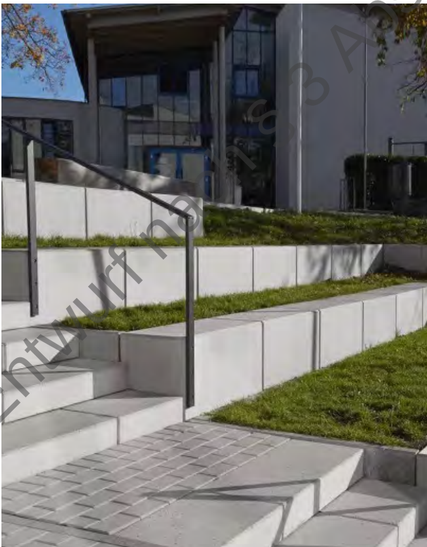
Abb.048 Betonsitzstufen mit Begrünung
