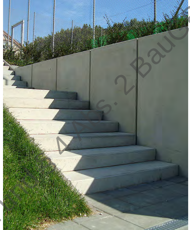
Abb.047 Betontreppenstufen und Stützmauer
