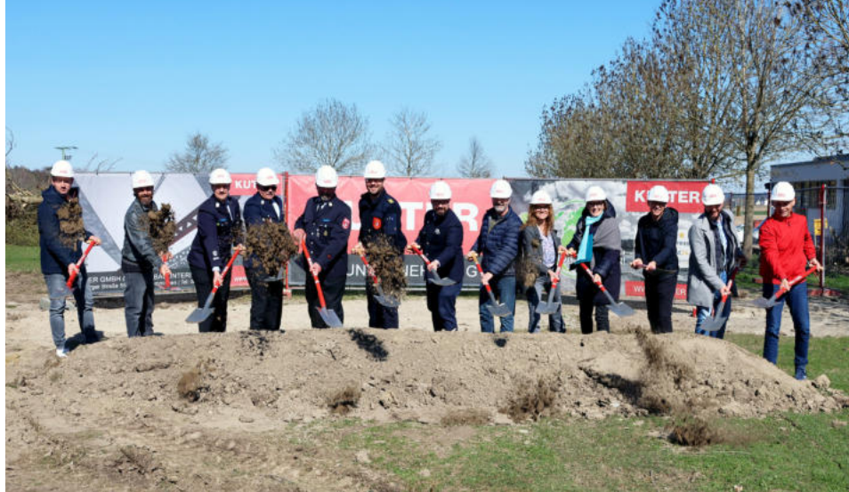
Die Projektbeteiligten führten den symbolischen Spatenstich zum Beginn des Neubaus der Feuerwehr Eisenburg durch.
