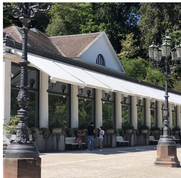
Abb. 43: Sommerlicher Wärmeschutz für das Gebäude inklusive beschattete Bänke in Baden-Baden [1]
