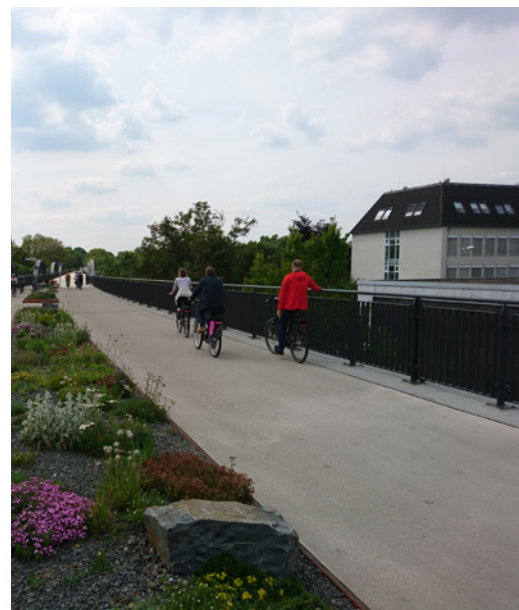
Abb. 49: Heller Belag auf einer Rad- und Fußgängerbrücke in Mülheim/Ruhr [2]
