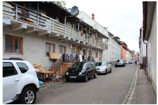
Straßenraum, An der Kaserne
