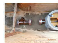
Kanaleumierung Zusammenschluss Manschetten
