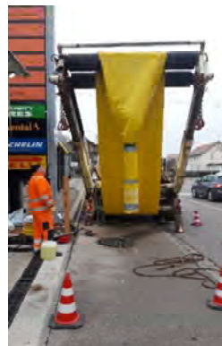
Einbau eines Schlauchliners DN 500 Allgäuer Straße/ Schweizer Ring
