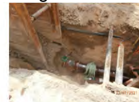
Kanaleumierung Steinzeugleitung/Abzweige
