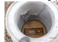
Kanaleumierung GFK Schachttunterteil
