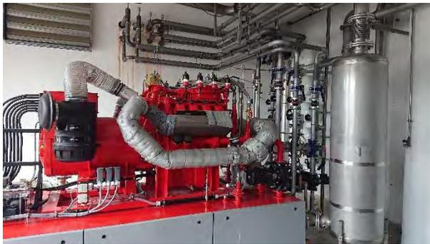
Somit stehen jetzt zwei weitgehend identische Blockheizkraftwerke zur Verfügung. Insgesamt wurde mittels der beiden BHKWs 2.380.633 kWh Strom aus dem Klärgas erzeugt. Die Eigenstromerzeugung betrug im Jahr 2020 ca. 55,19 %.
