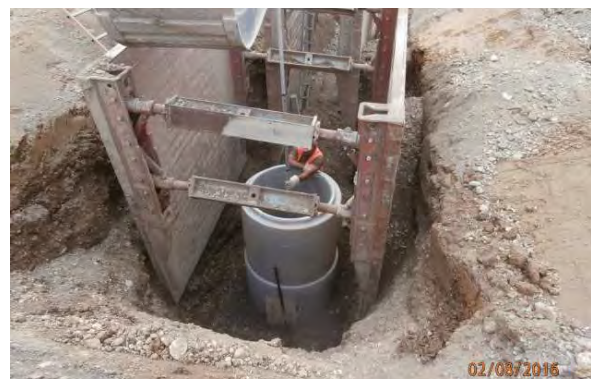
Kanalverlegung Oberer Buxheimer Weg
