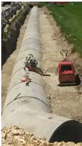
Ablaufkanal DN 1400 aus Stahlbeton
