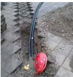
Kabelverlegung Vodafone – Kalchstraße/Hallhof
