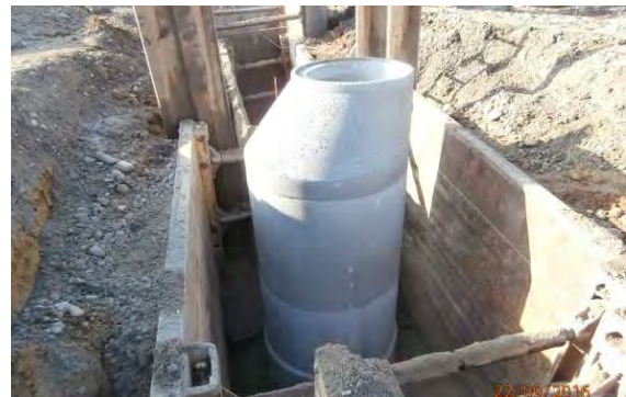
Kanalverlegung Dobelhalde BA 2
