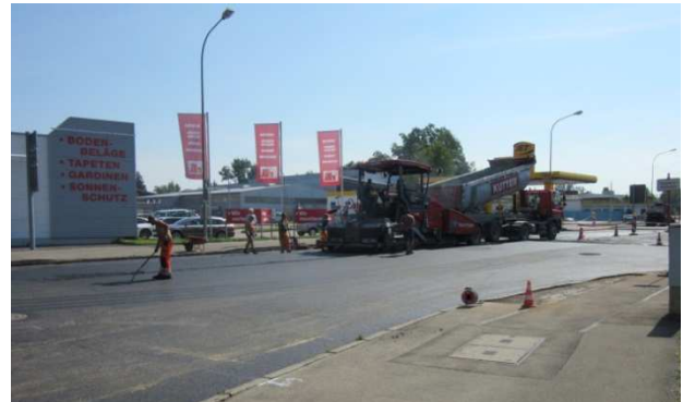
Asphaltdeckeneinbau, Schleiferplatz
