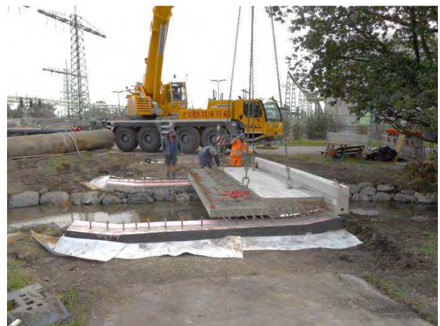
Einbau Betonfertigteil, Oktober 2016, Brücke BW 51
