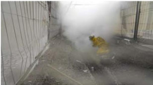
Freilegung der Fuge durch Hochdruckwasserstrahlen
