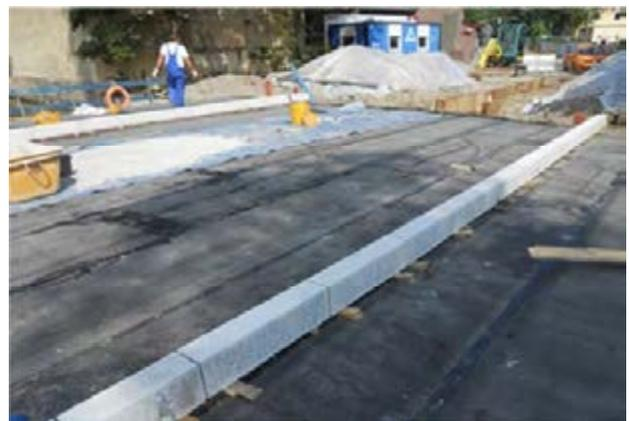
Setzen der Bordsteine auf der abgedichteten Brückenplatte
