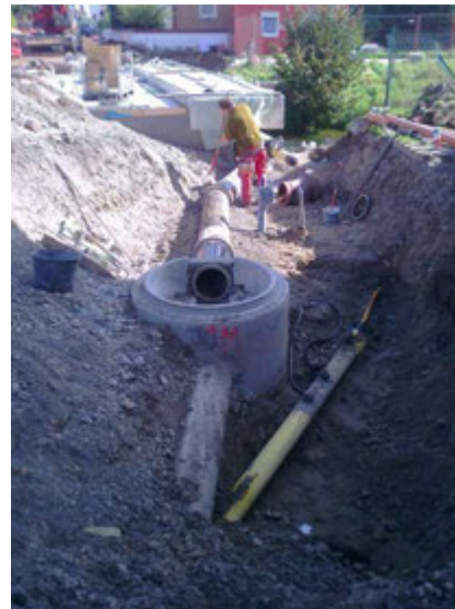
Kanalbaustelle Grünenfurter Straße
