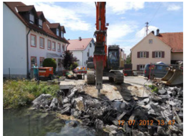
Abbruch alte Brücke
