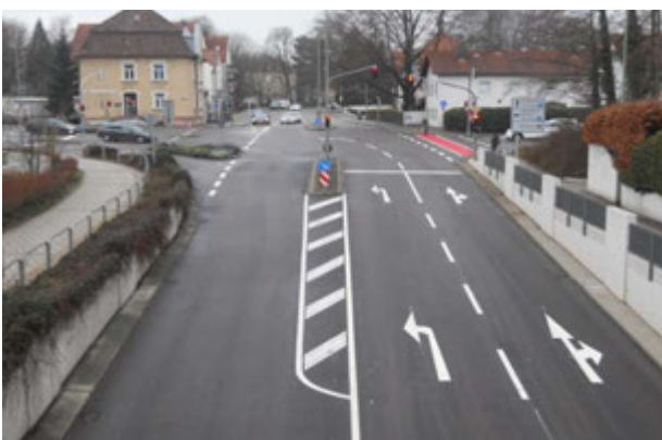
Fahrbahnmarkierung in der Lindenbadunterführung
