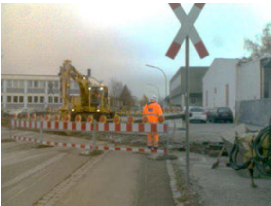
Gleisarbeiten am BÜ Oberbrühlstraße
