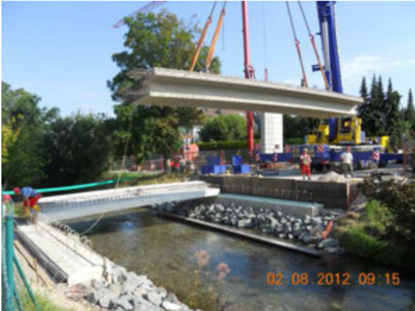
Einheben der Brückenfertigteile
