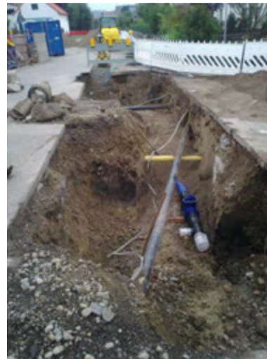
Wasserleitungsverlegung Fischerstraße
